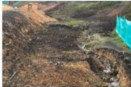
Fotografía 1 Zanjas drenantes previas a la instalación de filtros Fuente: Consorcio Generación Ituango, 2014.
