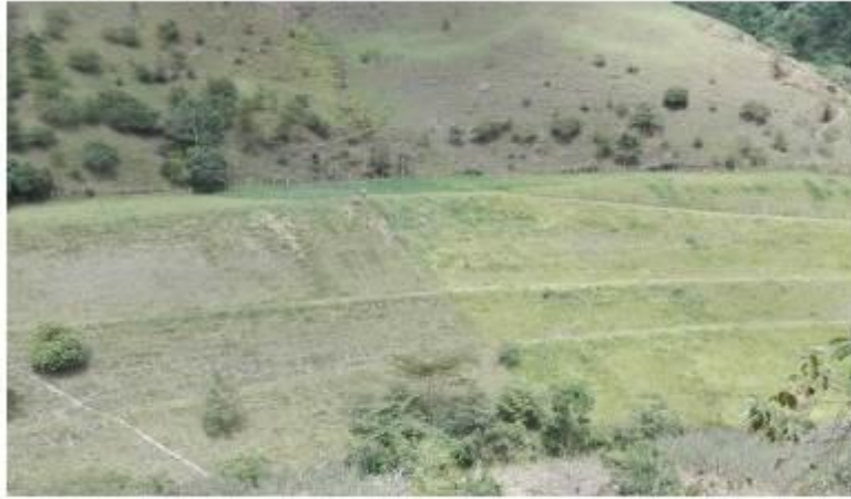
Fotografía 4 Depósito finalizado y en proceso de revegetalización.
