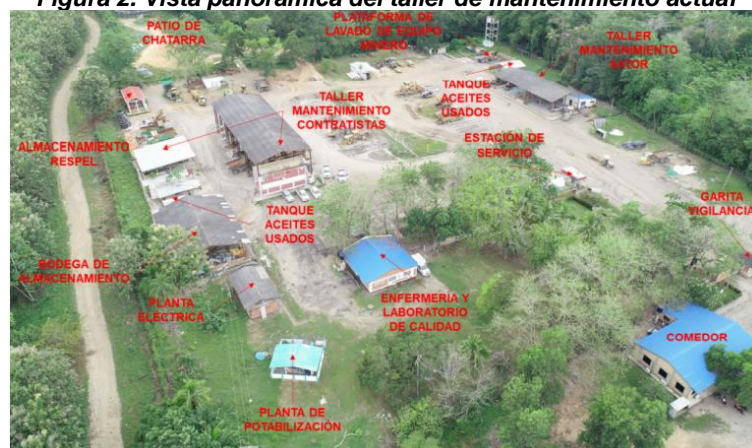
Figura 2. Vista panorámica del taller de mantenimiento actual
