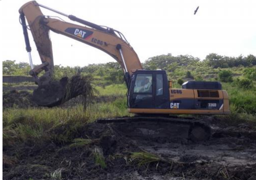
Figura 6. Remoción de la capa de suelo del terreno
