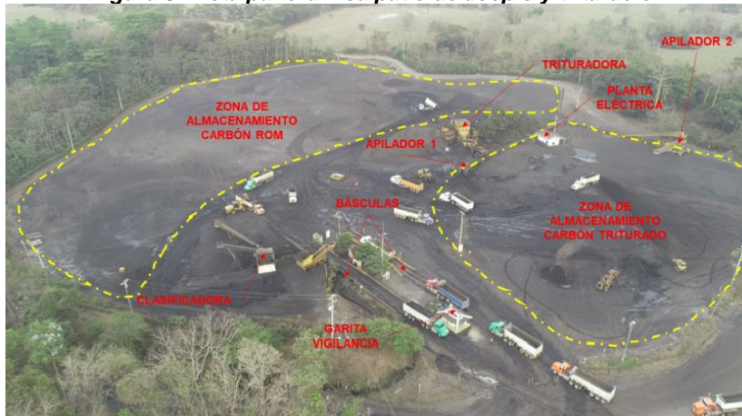
Figura 3. Vista panorámica patio de acopio y trituración
