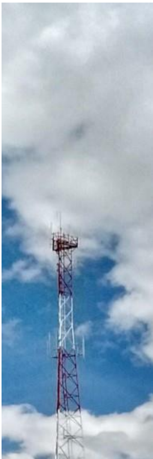
Vista torre de 60 m
