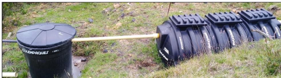
Figura 4. Sistema Manejo de Aguas Residuales Domésticas
