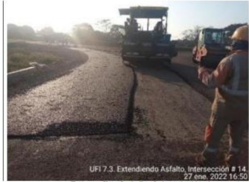
Fotografías 3, 4, 5 y 6. Instalación de mezcla asfáltica en la vía Perimetral aeropuerto de Tolú.
