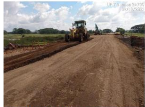
Fotografías 7 y 8. Instalación base granular en la vía Perimetral aeropuerto de Tolú
