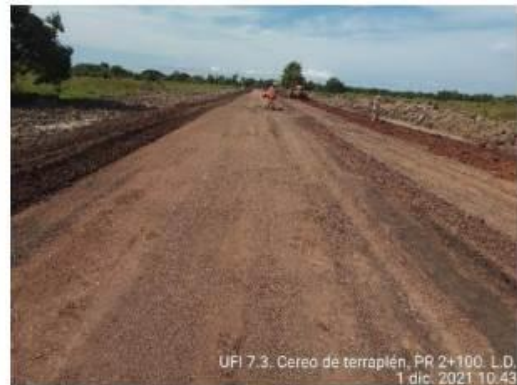
Fotografías 7 y 8. Instalación base granular en la vía Perimetral aeropuerto de Tolú
