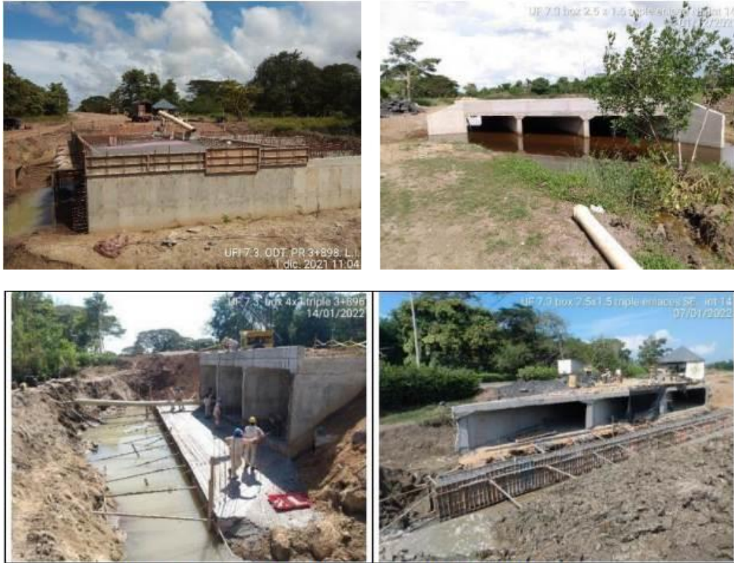
Fotografías 13, 14 , 15 y 16. Construcción ODT's en la Vía Perimetral aeropuerto de Tolú
