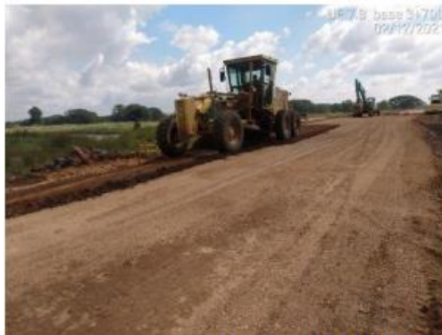
Fotografías 7 y 8. Instalación base granular en la vía Perimetral aeropuerto de Tolú
