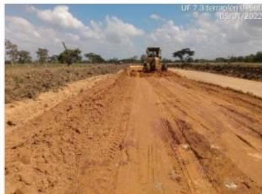
Fotografías 9, 10, 11 y 12. Instalación terraplenes en la vía Perimetral aeropuerto de Tolú
