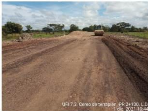
Fotografías 7 y 8. Instalación base granular en la vía Perimetral aeropuerto de Tolú
