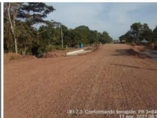
Fotografías 9, 10, 11 y 12. Instalación terraplenes en la vía Perimetral aeropuerto de Tolú
